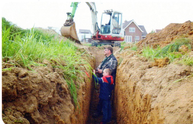
Hoe diep moet die sleuf zijn?
