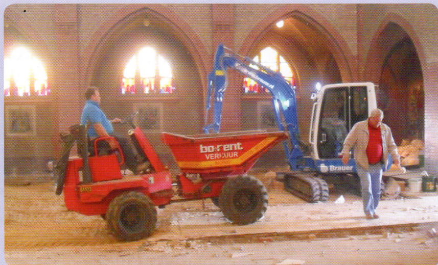
In de voormalige kerk in Steyl wordt hard gewerkt om het gebouw geschikt te maken en in te richten als museum voor de OLS-Federatie. De hele vloer ligt eruit om een meer energiebesparende vloerverwarming aan te kunnen leggen. / Foto: Luc Wolters
